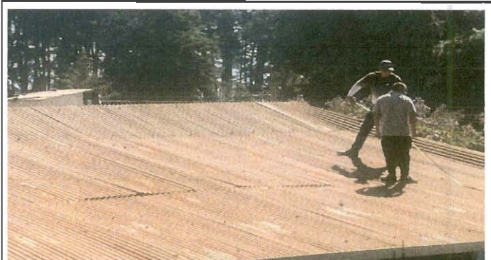
Foto 2: CAMBIO DE LAMINA DE ZINC POR LAMINA TROQUELADA, EN MODULO DOS DE TRES AULAS.
