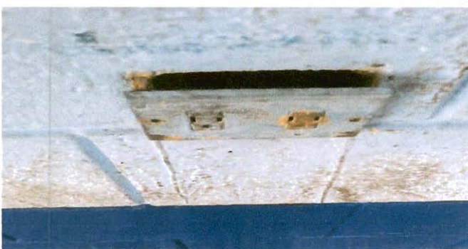
Foto 9: CAMBIO DE TOMACORRIENTES.
