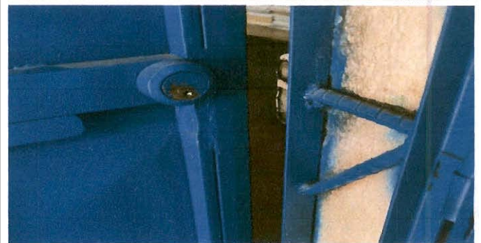
Foto 10: CAMBIO DE CHAPAS EN PUERTAS DE VARIAS AULAS.
