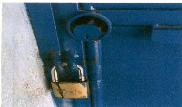
Foto 5: CAMBIO DE CHAPAS EN VARIAS PUERTAS.
