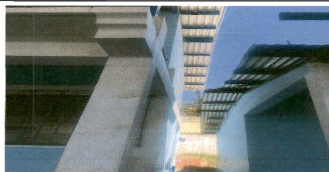
Foto 11: CONSTRUCCIÓN ESTRUCTURA DE METAL PARA CUBRIR MODULO DE GRADAS, ACCESO AULAS SEGUNDO NIVEL.
