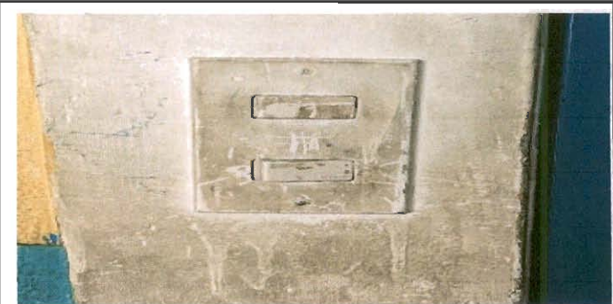
Foto 12: CAMBIO DE APAGADORES.
