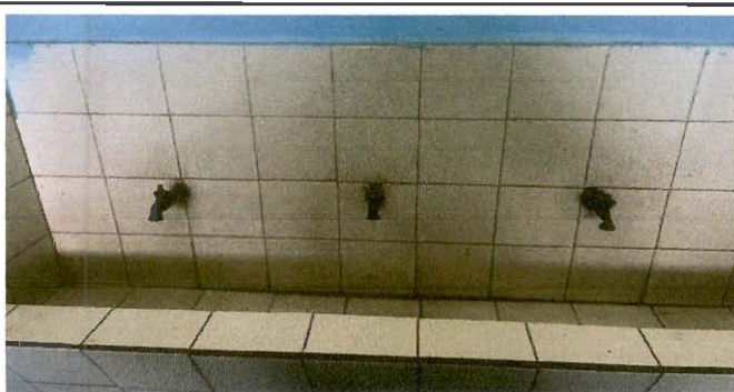
Foto 3: CAMBIO DE CHORROS EN SANITARIOS Y PILAS.
