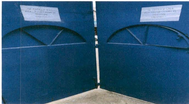
Foto 7: REPARACIÓN COMPLETA DE PORTÓN PRINCIPAL DE TRES HOJAS.
